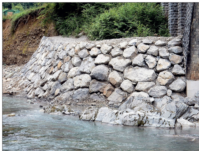
▲ Situation après travaux (juin 2022, François Rebillard, CRÉLOC)
