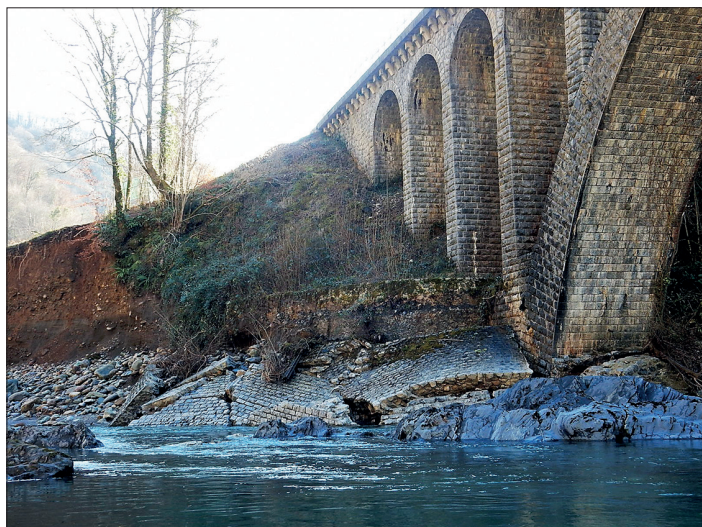
▲ Situation avant travaux (février 2022, François Rebillard, CRÉLOC)
