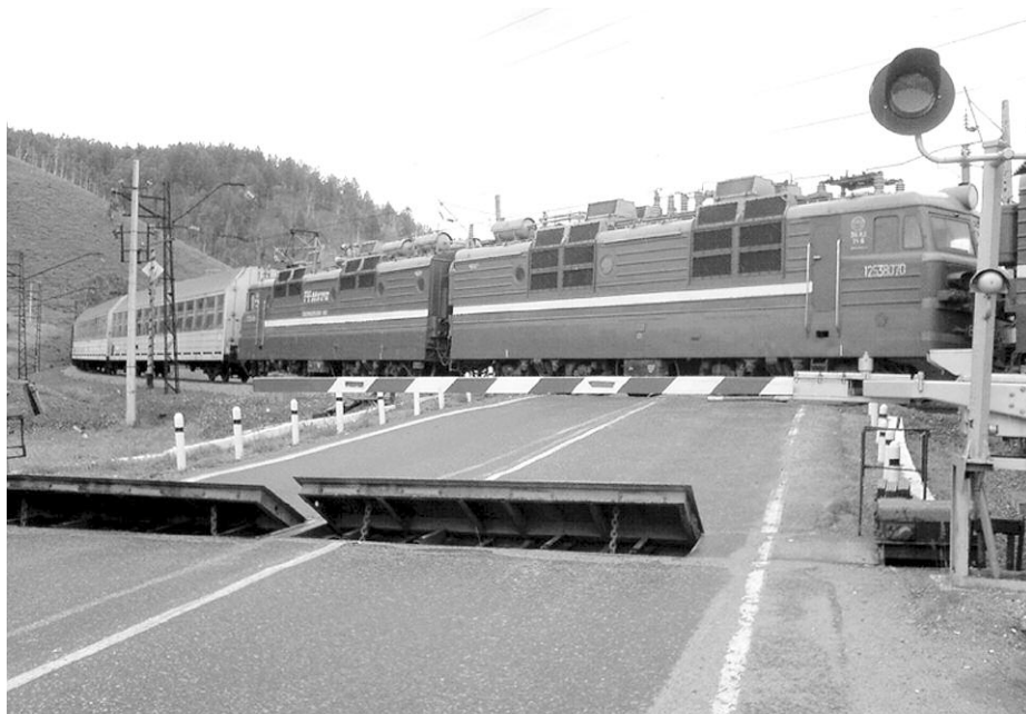
Système russe de protection de passage à niveau. On voit d'abord que les demi-barrières sont éloignées de la voie, puis que les plaques qui se relèvent n'interdisent pas le dégagement. On trouve un système analogue sur les têtes des ponts mobiles.
