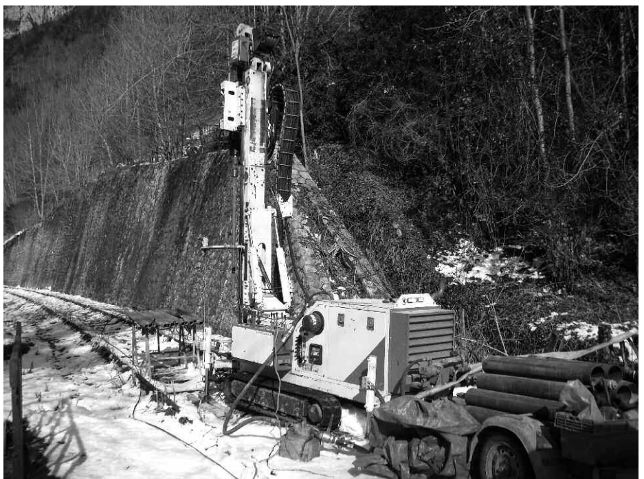
Carotteuse effectuant des sondages aux abords des Fontaines d'Escot.
