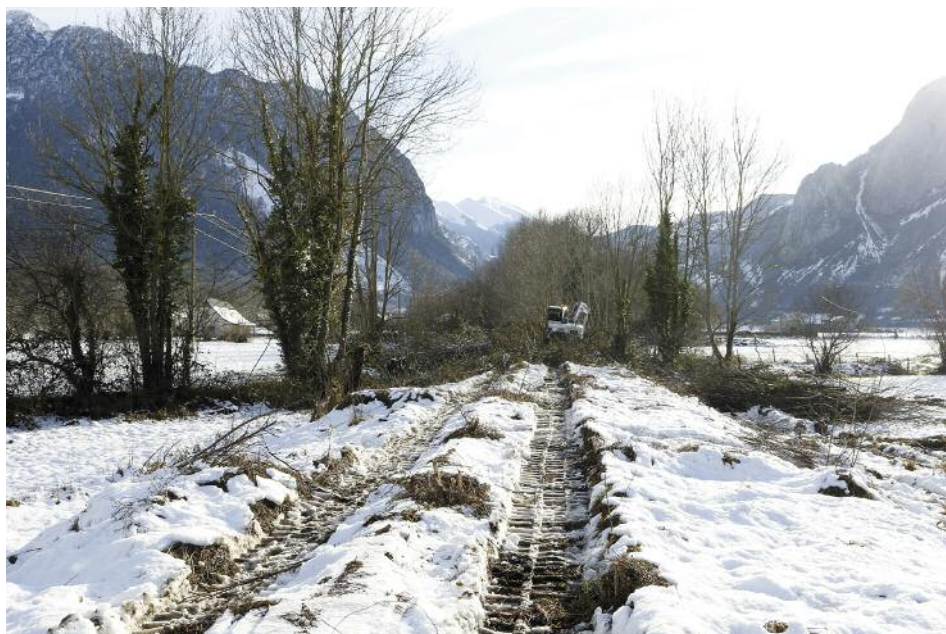
Ce janvier 2018, au-delà de Bedous, on débroussaille activement la ligne. La direction est bien celle de Canfranc.
