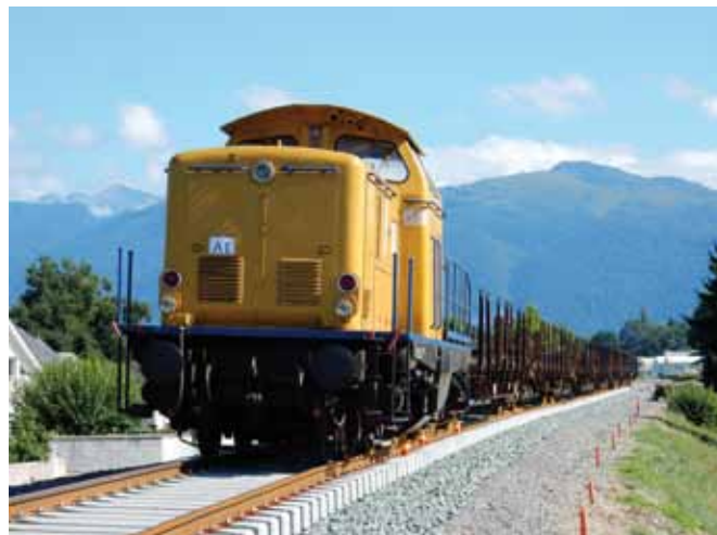
Juillet 2015, un des tous premiers trains de travaux engagé au delà d'Oloron Sainte-Marie, en direction de Bedous. (Cliché Créloc-François Rebillard).
